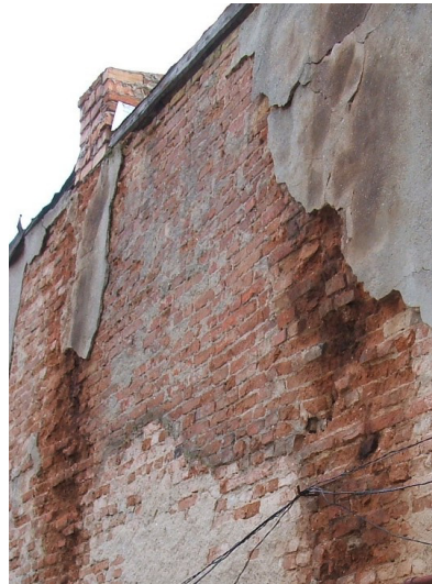
Coș de fum deteriorat și calcan, care se pot prăbuși în stradă la seism
