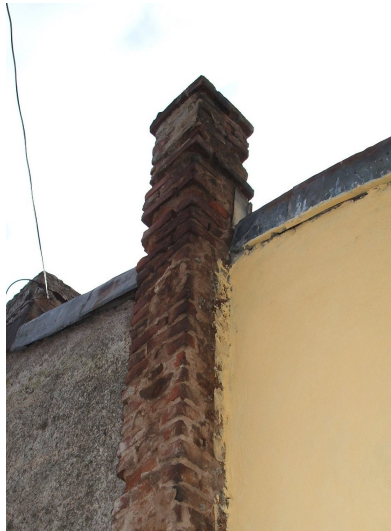
Coș de fum deteriorat și calcan, care se pot prăbuși în stradă la seism
